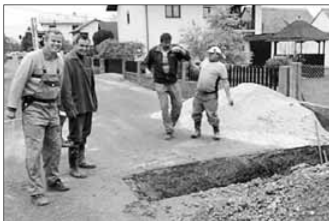
Odprava napake na vodovodnem omrežju v Drevesniški ul. v Račah
