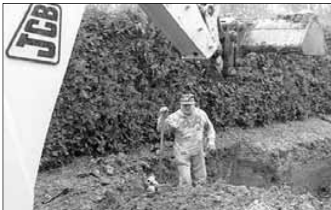
Prestavitev vodovoda ob Ljubljanski cesti v Račah
