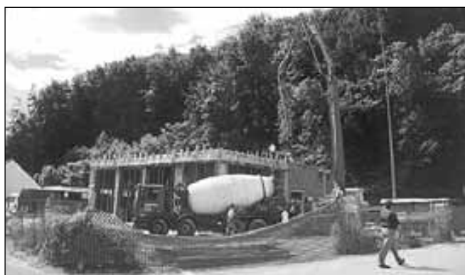
Betoniranje plošče
