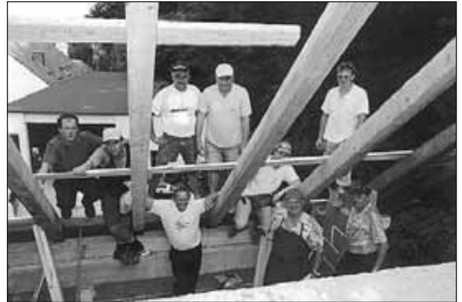
Postavljanje ostrešja, pri čemer mojstrom vsak dan pomaga ekipa gasilcev iz druge vasi v KS Fram
