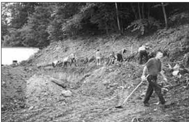
Ročna zemeljska dela
