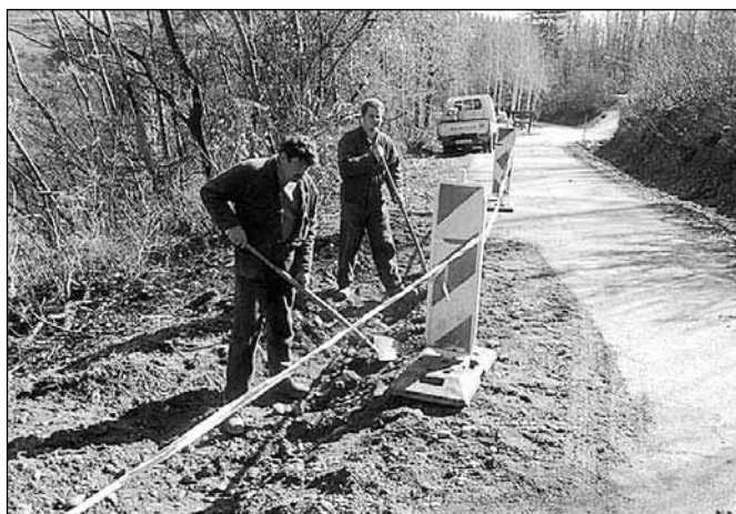
Zaščita in sanacija občestnega zemeljskega plazov v Gradišču
