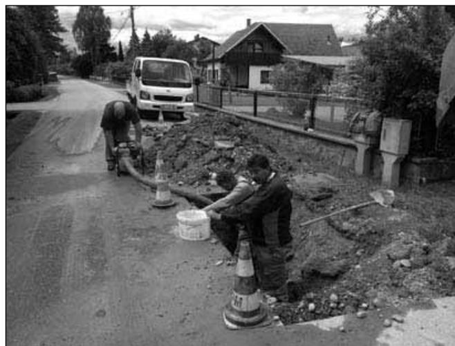
Popravilo vodovoda v Ješenci
