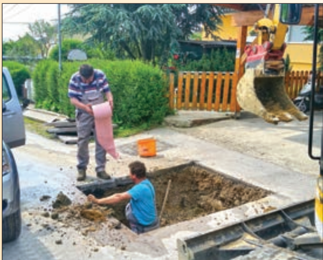
Popravilo okvare na javnem vodovodnem omrežju v Morju
