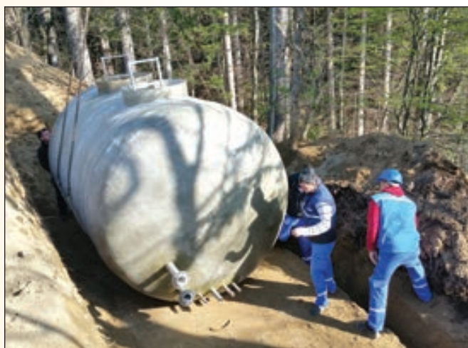
Vgradnja vodohrana v Planici
