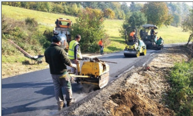
Asfaltiranje cestišča v Framu - Varta
