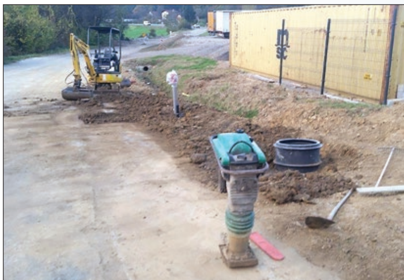
Poleg že v tekstu navedenega je bila letos v Morju izvedena tudi širitev hidrantnega omrežja
