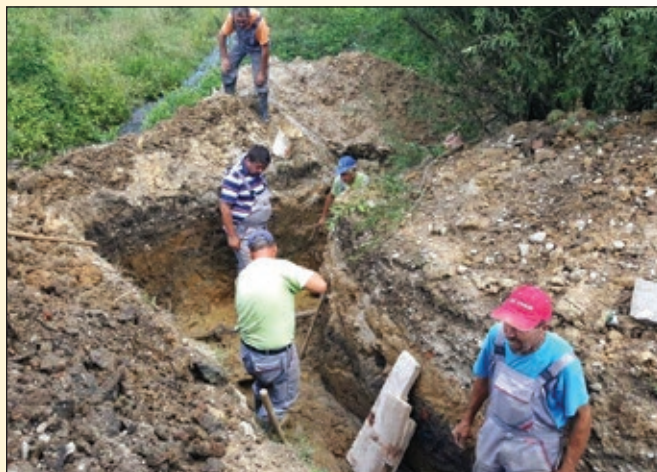
Zamenjava vodovodne cevi ter prevezave vodov na Kolodvorski ulici v Račah
