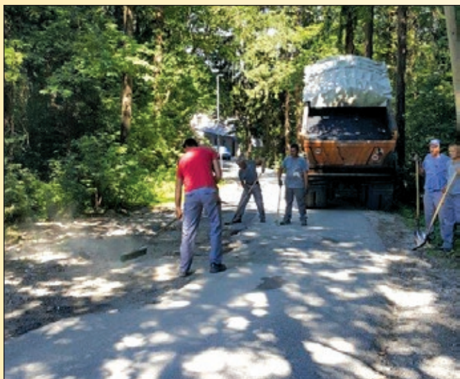
Sanacija in asfaltiranje cestišč v Morju
