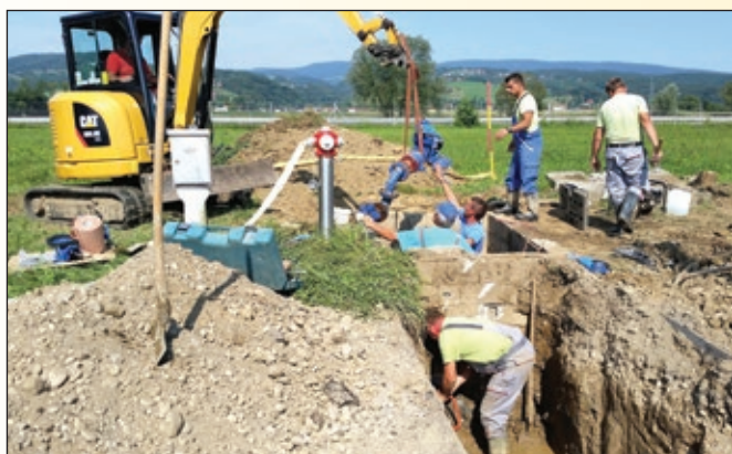
Prevezava vodovoda z menjavo zasunov v Framu
