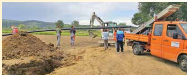
Zamenjava povezovalnega vodovoda Fram-Rače Foto: Gregor Ovnik
