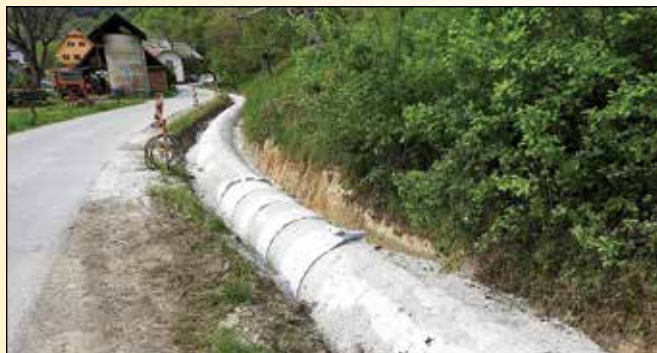
Regulacija potoka oz. meteornih vod v Morju, v sklopu izgradnje javnega kanalizacijskega omrežja
