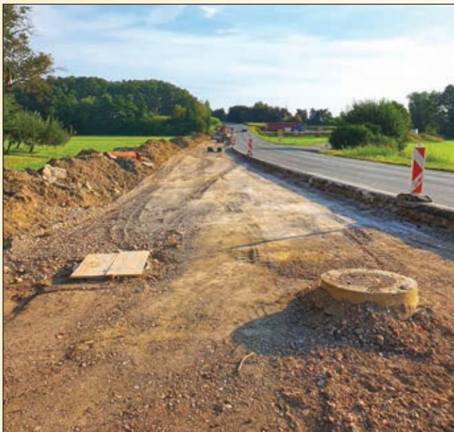
Izgradnja mešane površine za pešce in kolesarje v Morju, na odseku Mlinska ulica-Prisojna ulica
