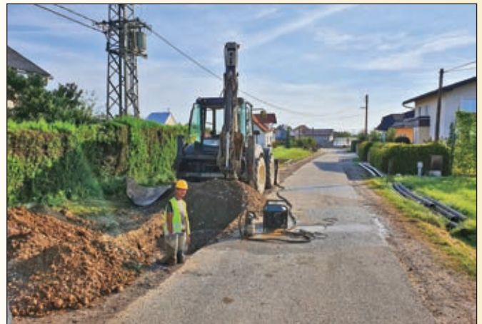
Zamenjava vodovodnega omrežja v delu Ješence s sopolaganjem komunalnih vodov
