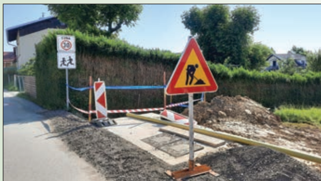
Nova reducirna postaja za uravnavo tlaka v vodovodnih ceveh v Morju
