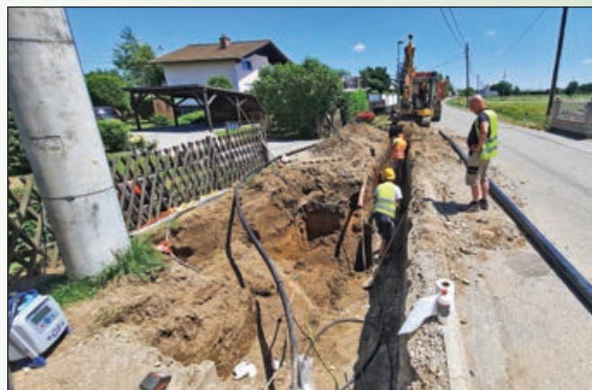
Zamenjava transportnega vodovoda
