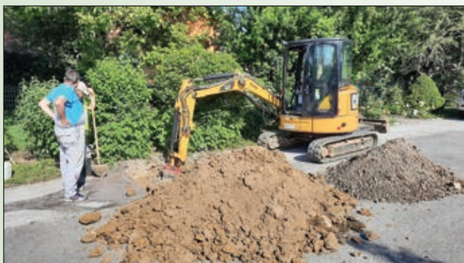
Prezava hišnih priključkov na novo vodovodno cev
