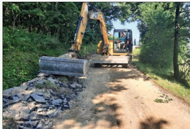
Obnova lokalne ceste - Planica
