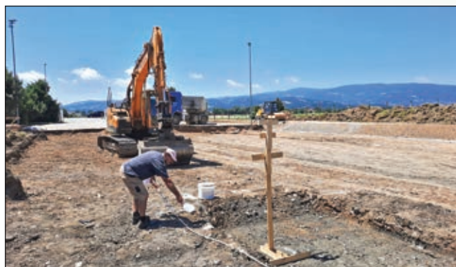
Posnetek z gradbišča bodočega rekonstruiranega ZC Rače; 14. 6. 2021
