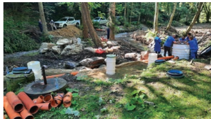
Sanacija vodnega izvira Eberli
