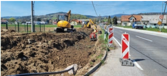
Izgradnja kanalizacije Greif - Tepe
