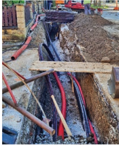
Obnova vodovoda na odseku Brezula – Podova.
