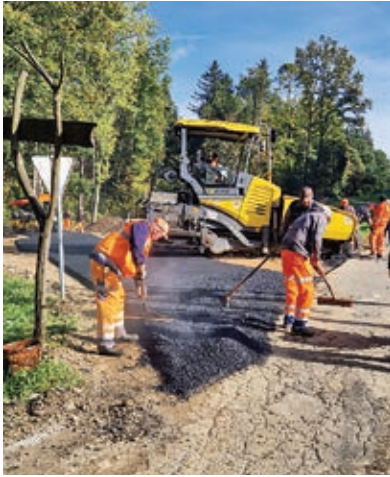
Obnova ceste v Planici – odsek Šlamberger.
